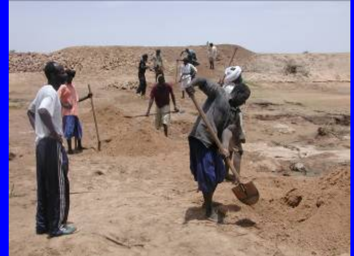
Collecte des eaux de ruissellement : diguette
